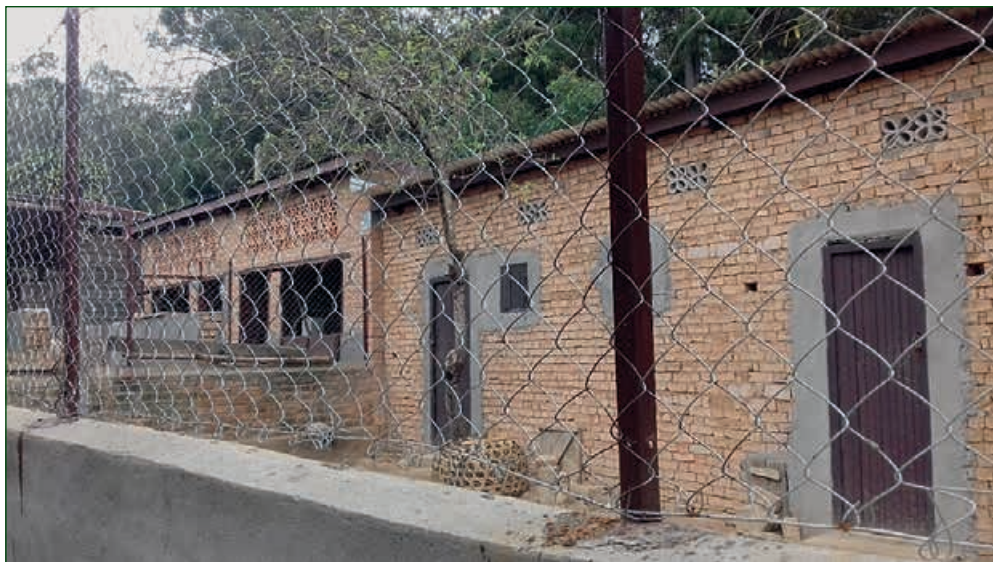
Gebäude für Schweine- und Hühnerstall nach der Sanierung
