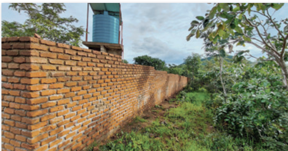
Wassertank und Zaun
