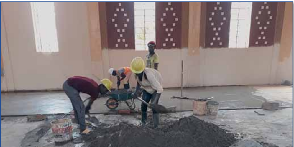
Bodenerneuerung und Wiederherstellung der originalen Wandfarben
