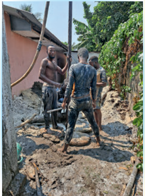
Verlegung der Wasserleitungen
