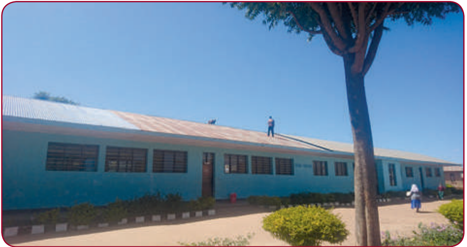
Renovierung des Eisenblechs
