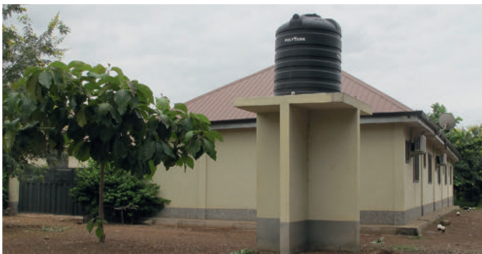
St. Franz Xaver-Kirche außen mit Wassertank
